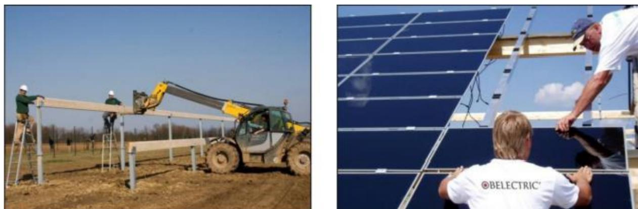
Illustration 35 : Montage des structures porteuses et des modules
